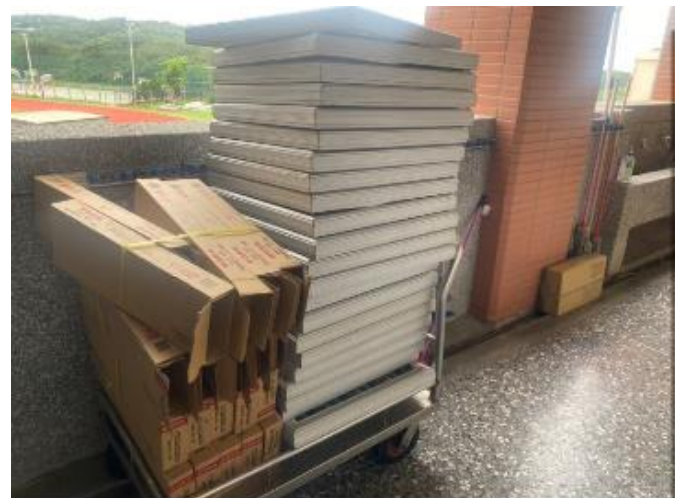
拆卸更換後T5燈具
