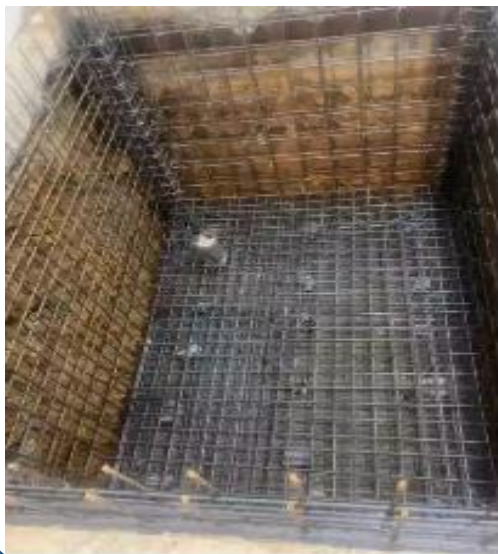
電梯機坑施作
