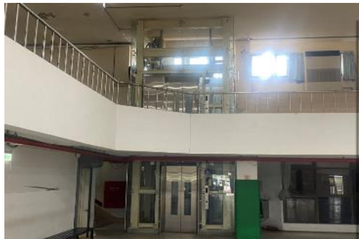
電梯工程驗收完成
