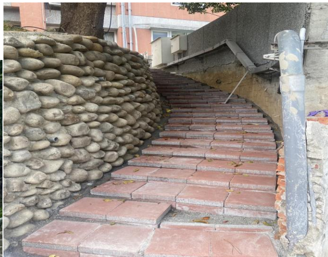
新建擋土牆及階梯
