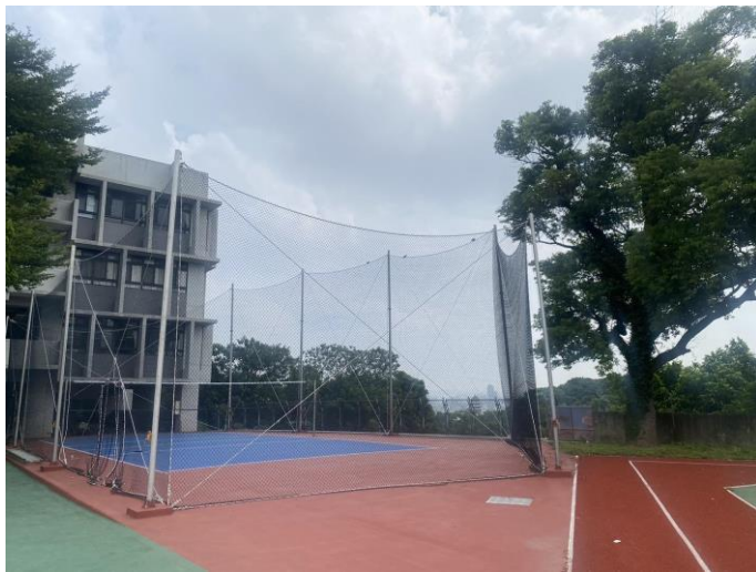
新建排球場工程
