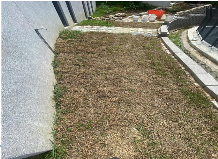
加設雨水排水道及加高擋 土牆和種植草皮
