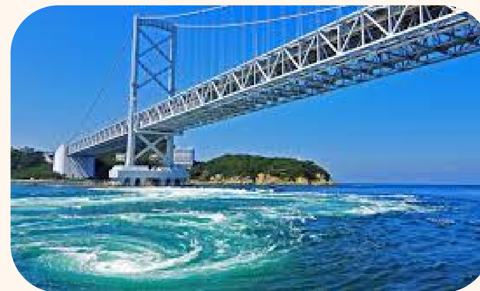
鳴門渦之道(德島)
